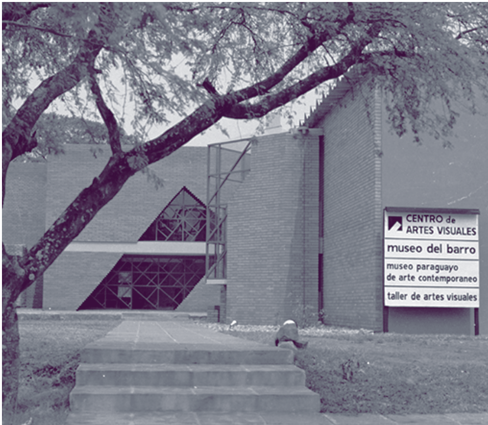
Museo en obras. 1987
