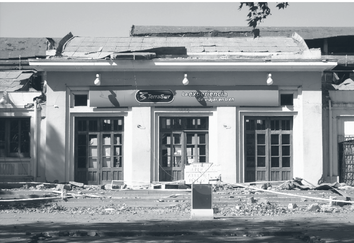
Estación: Al igual que muchas construcciones, destaca la caída del remate decorativo logrado mediante la elevación de la fachada, en muchos casos soporte de iconografía de influencia prehispánica.
