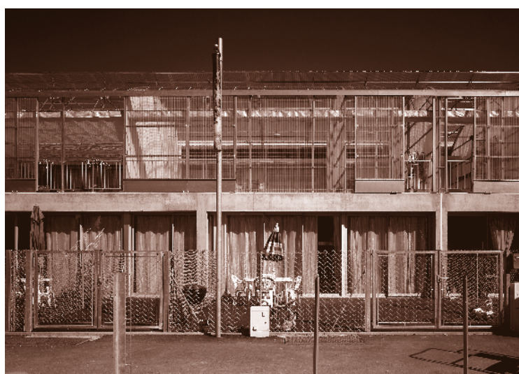
Vivienda Social Mulhouse. Fotografía Philippe Ruault.
