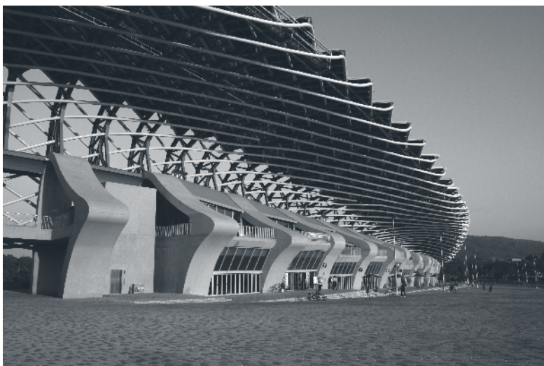
Fig. 4: Techumbre del estadio desde el exterior. Fotógrafo: David Reid.
