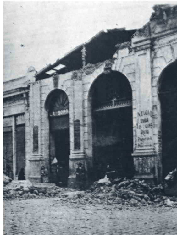
Mercado: Fotografía del Mercado Central de Talca para el terremoto de 1928, aparecida en la revista Arquitectura y arte decorativo . Se aludía a que gracias a su construcción en hormigón, no había sufrido mayores daños. Hoy se estudia la demolición del edificio completo.
