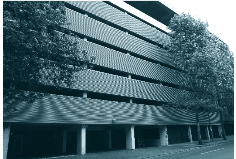
Edificio de estacionamientos Moneda en la actualidad.
