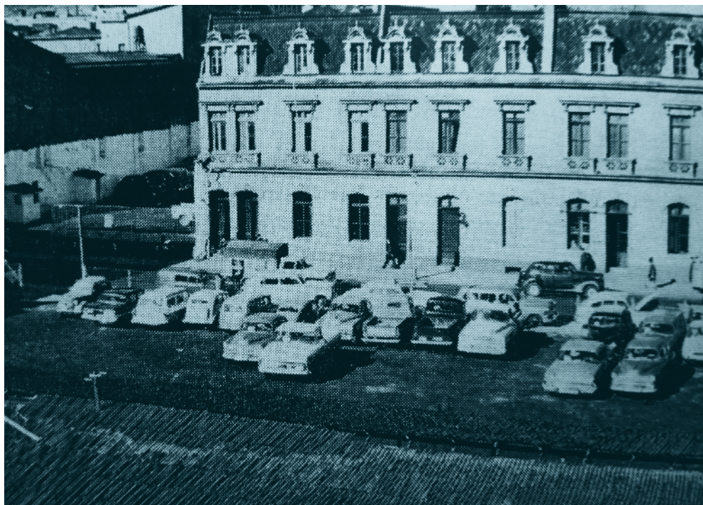
Playa de estacionamiento en la esquina de Teatinos con Catedral. Revista de la Construcción número 5, octubre de 1962, pág. 16.
