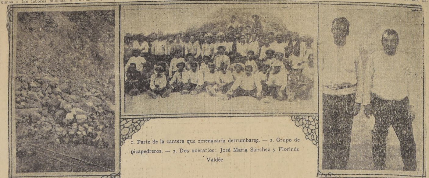
1. Parte de la cantera que amenazaría derrumbarse. — 2. Grupo de picapedreros. — 3. Dos operarios: José María Sánchez y Florindo Valdés.
