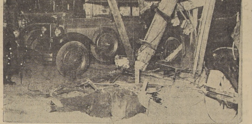
El obrero Osvaldo Latorre González yace cadáver, horriblemente triturado, al lado de uno de los postes que fueron cortados por el caldero como un serrucho...
