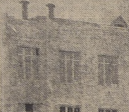
Edificio del molino Castilla, en el pueblo de Chimba
