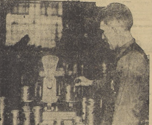
Pesando los pistones de un motor para asegurar su uniformidad
