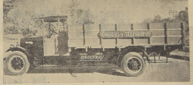
Modelos E de 1 y media tons. de carga útil. Tiene 780 kilos de reserva para carrocer
