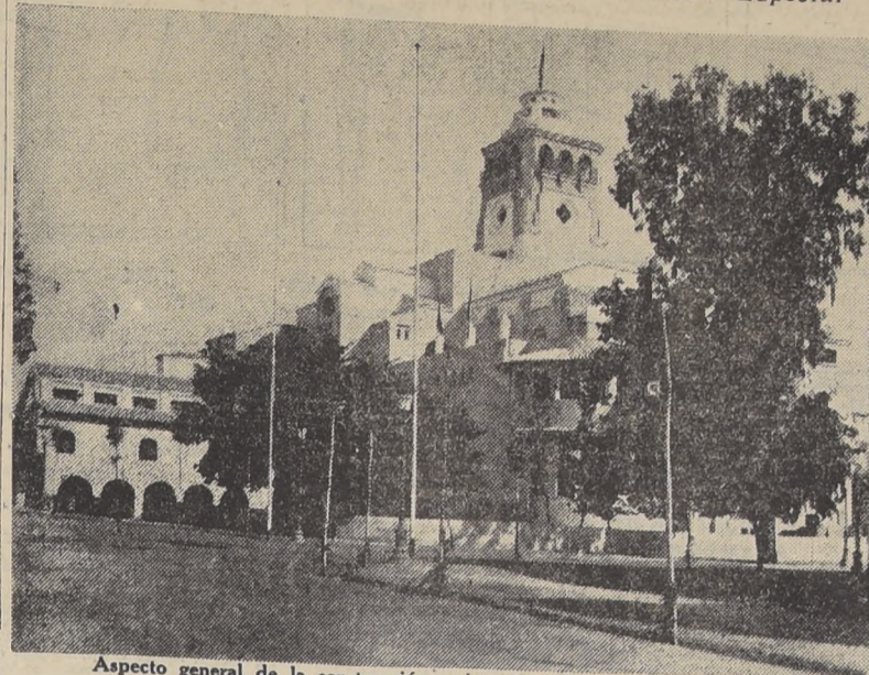
Aspecto general de la construcción, visto desde la Avenida Chile
