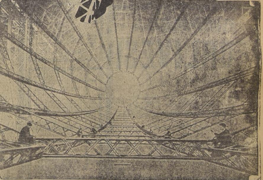
Una vista tomada durante el proceso de la construcción de la aeronave. Toda la armadura interior, del tipo rígido, es de duraluminio y en ella van los balones de gas.
