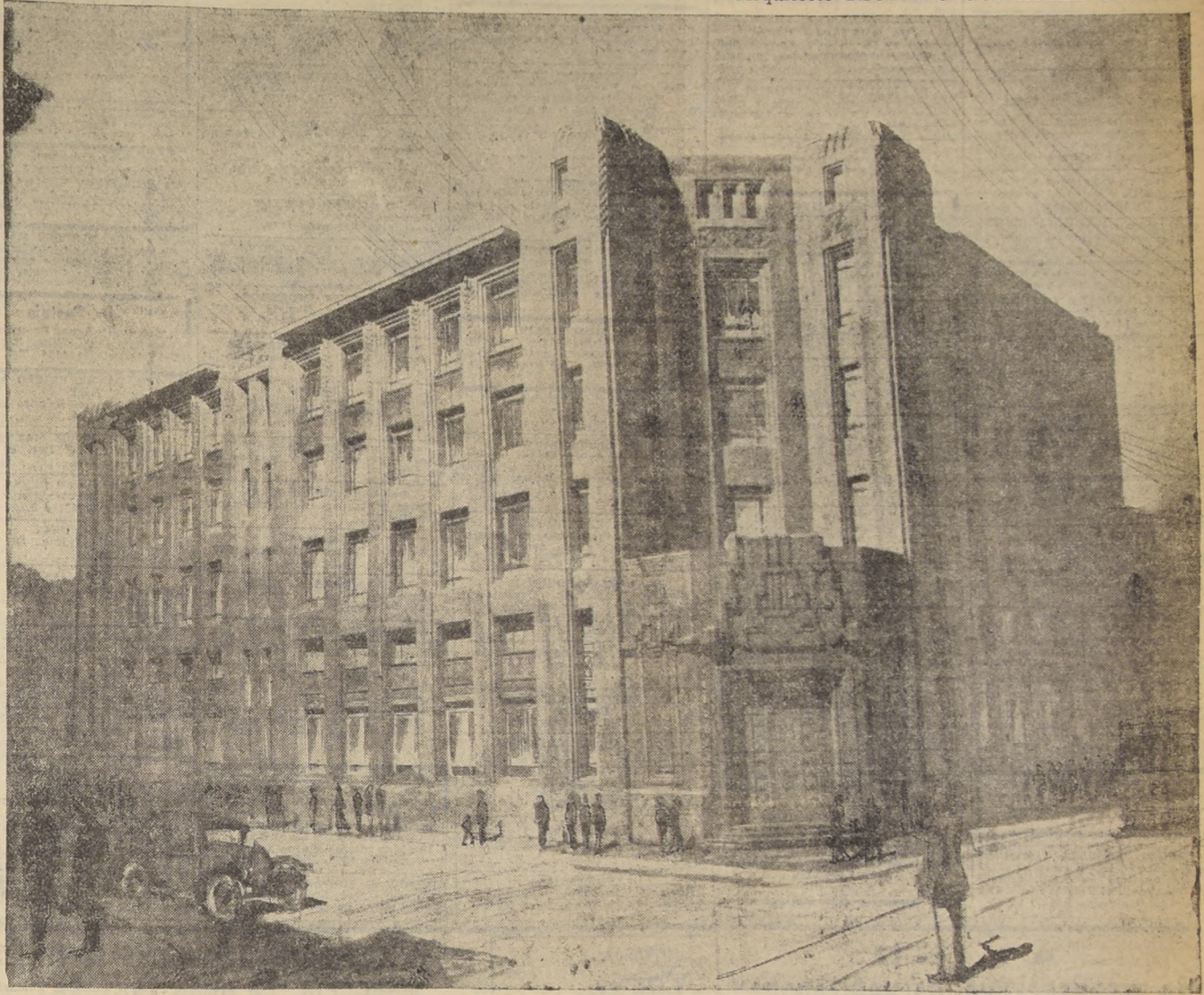
Perspectiva de las fachadas vistas desde la esquina de Huérfanos con Morandé
