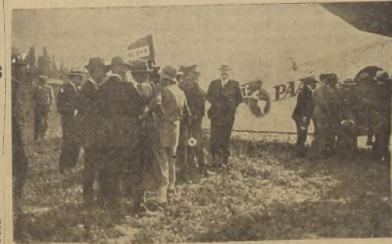
Un aspecto del campo de Los Cerrillos, en la tarde de ayer.
