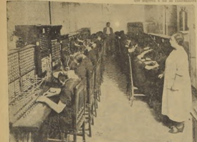
ANTES — SEVILLA. ANTIGUA CENTRAL MANUAL, CON CUADROS DE OCHO TIPOS DIFERENTES, NEGACION DEL CONCEPTO DE LO STANDARD
