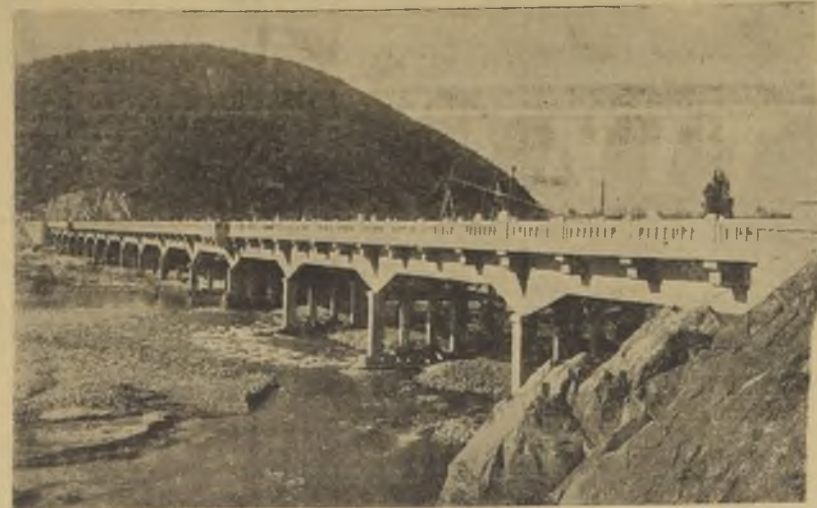
Puente Chocón en Melipilla sobre el río Maipo. La Poza en Colchagua, Chocón en el camino de Concepción a Valdivia, La Polvareda en San Bernardo, Paso Inferior Malloco en Melipilla y dos pasos inferiores en el longu-
