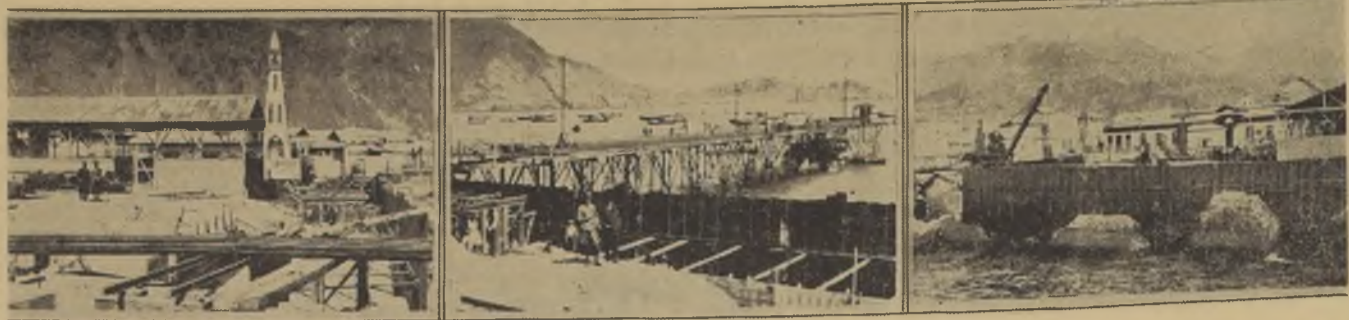
Construcción de la muralla de concreto y de la muralla de Tabla Estaca
