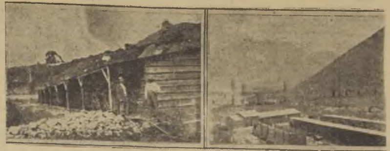
Trabajos de iniciación de las obras del tranque de Huintil.
