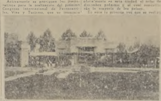
Uno de los pabellones del Palacio de Danzas, cuya construcción está muy avanzada.
