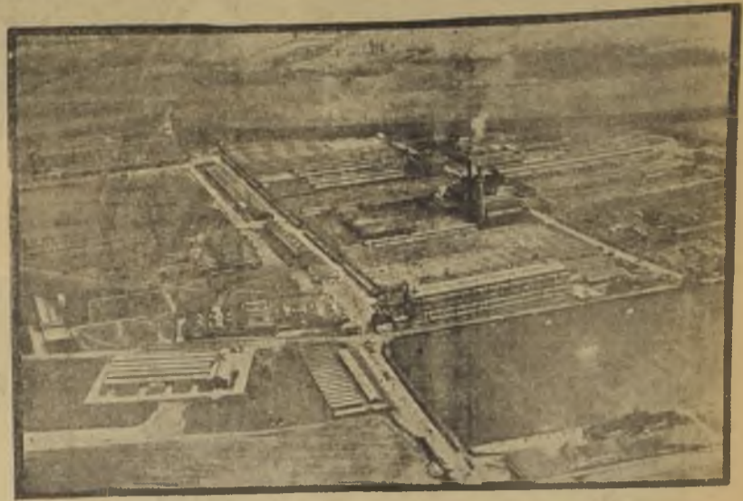
Una vista general de Fort Dunlop y los alrededores de Birmingham, mostrando a la mano derecha en primer término el inmenso bloque de oficinas recién edificadas. La fábrica ocupa un área de 350 acres y funciona enteramente por electricidad tomada de una instalación de fuerza motriz de turbinas, a vapor de 22,000 HP, que produce 44 millones de unidades al año.
