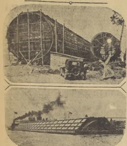
Dentro de poco quedará terminado el túnel submarino que unirá a Detroit con Windsor, variando en sus secciones, actualmente en construcción, pueden verse en las dos fotografías. En la parte inferior se ve una de las secciones, remolcada para sumergirla en su lugar.
