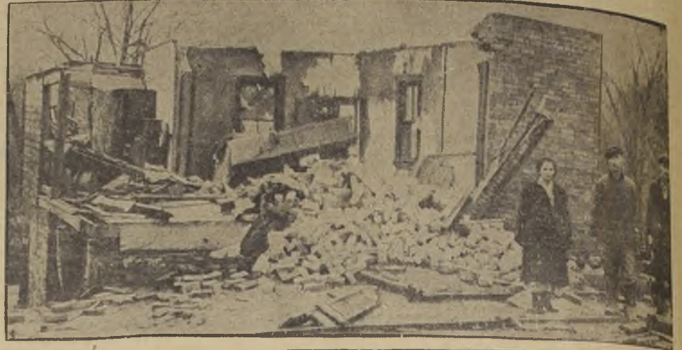
LOS EFECTOS DE UN FORMIDABLE CICLON. — Hace algunas semanas, un tremendo ciclón cruzó hacia el Oeste algunos de los Estados del Sur de la Unión, a una velocidad de doscientos kilómetros por hora. A su paso pocos fueron los edificios que soportaron la embestida. El grabado muestra una pobre familia de Rosenville, Kentucky, cuya residencia de dos pisos fue destruida por el huracán.
