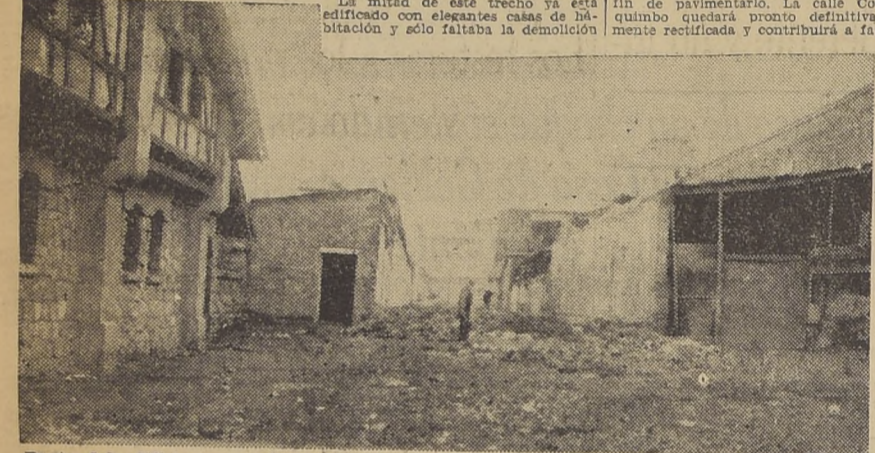
Parte del edificio que acaba de demolerse para la apertura definitiva de Coquimbo, frente a Lira
