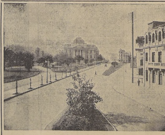
MUNICIPALIDAD DE SANTIAGO (Pavimentación). — Avenida del Parque Forestal
