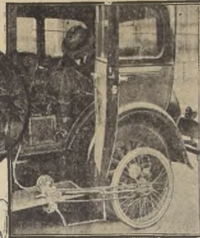
La "quinta rueda" hace funcionar el acelerómetro con toda precisión.
