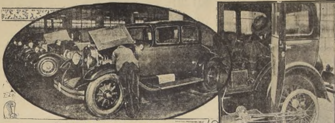
La prueba de los rodadores después de haber recorrido el automóvil centenares de millas sin el menor defecto. Las ruedas de atrás funcionan en los rodadores.
