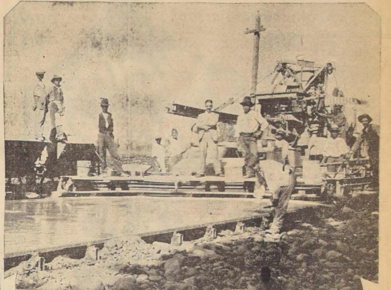
Camino de Santiago a Melipilla. — Máquina para el apisonamiento y acabado del hormigón de la calzada, trabajando en el kilómetro 8.
