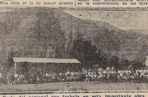
Parte del personal que trabaja en esta importante obra.
