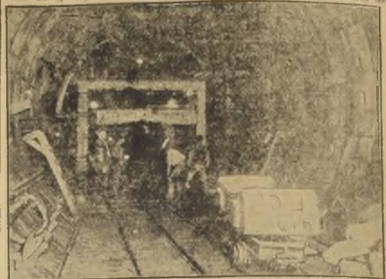
Cabecera de una de las secciones del túnel de la Ford ilustrando la maquinaria usada para horadar bajo tierra. Al frente se ve una de las planchas de concreto que se usaron para forrar el túnel. Este tiene un diámetro interior de 15 pies.
