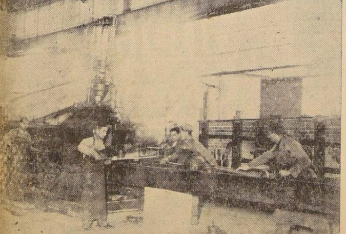
PRESA HIDRAULICA DE 1,000 TONELADAS.— FABRICANDO CASNERIAS DE BRONCE.
