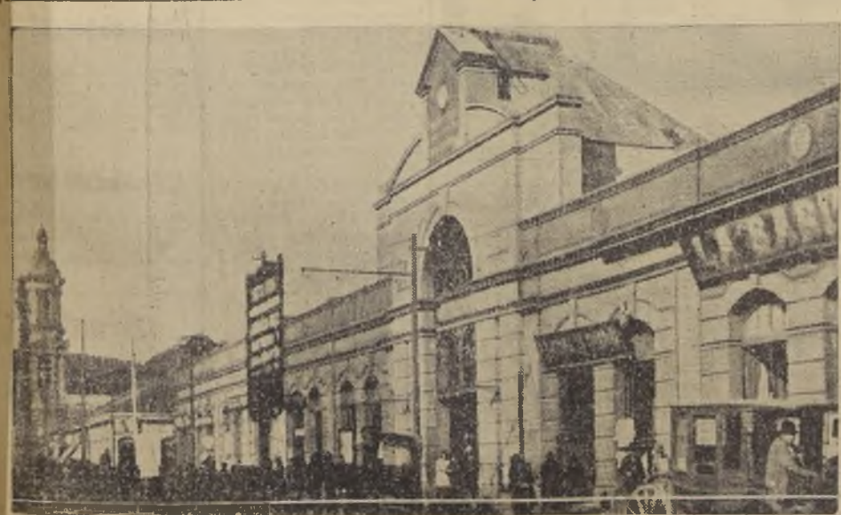
6.) El Mercado Municipal, donde la pesada del fenómeno causó mayores daños.
