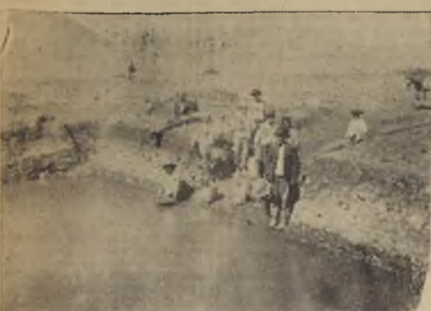
Uno de los grandes pozos construidos en Andacollo para el lavado de las tierras, de 100 metros cúbicos de capacidad se encuentra a 79 metros de altura y a 204 de la bomba.
