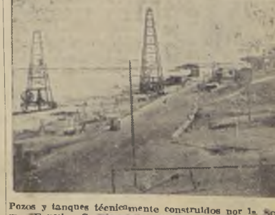
Pozos y tanques técnicamente construidos por la Sociedad Anónima "Faustino C. Piaggio", y que han dado hasta la fecha los mejores resultados
