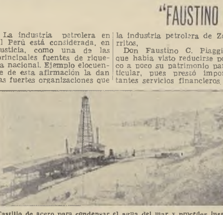
Castillo de acero para condensar el agua del mar y proceder luego a la respectiva destilación
