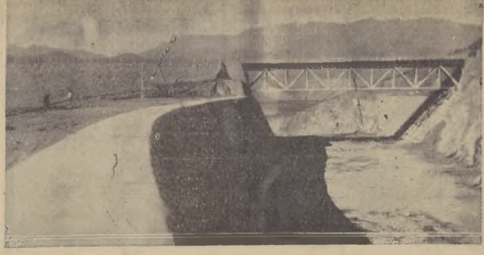
El gran rebalse del tranque de Recoleta, con una capacidad de más de 8.000m³ por segundo
