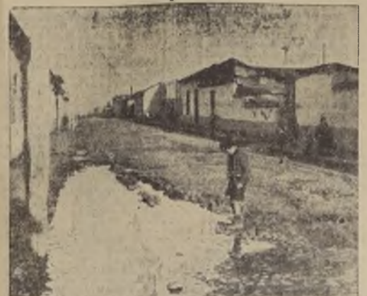
La calle Concepción, entre Arturo Prat y Chiloé. Puede observarse el pésimo estado del pavimento
