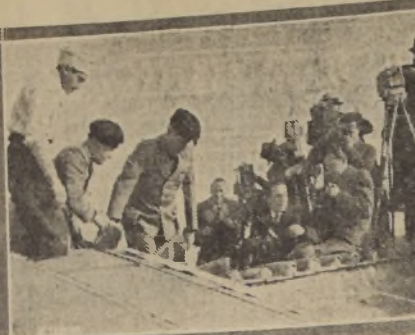
El Duce rodeado por los obreros, inicia la demolición de la sección romana en donde se construirá la Casa del Littorio
