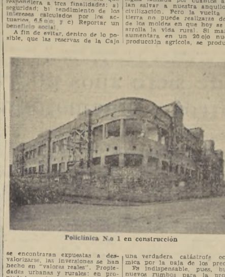
Policlínica N.º 1 en construcción
