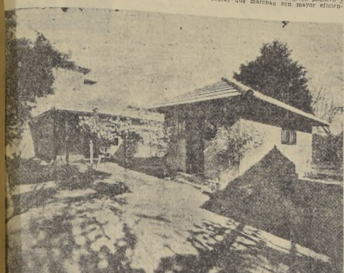
ONCHALI— Posta rural del tipo A-1, construida con bloques de yeso de Petorca. La casa habitación y la sala de hospitalización anexa se han habilitado utilizando casas de inquilinos que se han refaccionado para el caso. Los terrenos y las construcciones se deben a la generosa donación del señor Castor Aguirre L.
