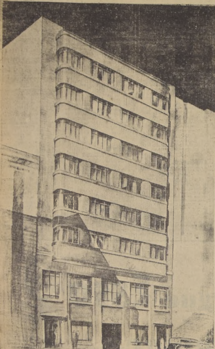
Seguimos nuestra labor de divulgación de las obras arquitectónicas recientemente terminadas, que ocupamos, hoy día, del edificio propiedad de las Compañías de Seguro "La República" y otras, ubicado en la calle de las Agustinas N.º 1137 al 41, San- Llamo especialmente la atención la feliz adición dada a su fachada, cuyas líneas y masas ajustadas a las más modernas tendencias de la Arquitectura, unidas a la sutileza con que han sido empleados diferentes materia- les como elementos decorativos, son una evidente manifestación de simplicidad, proporción y elegancia. Para ilustrar el criterio de nuestros lectores, destacamos entre otras, las principales dificultades que fué necesario salvar para lle-
