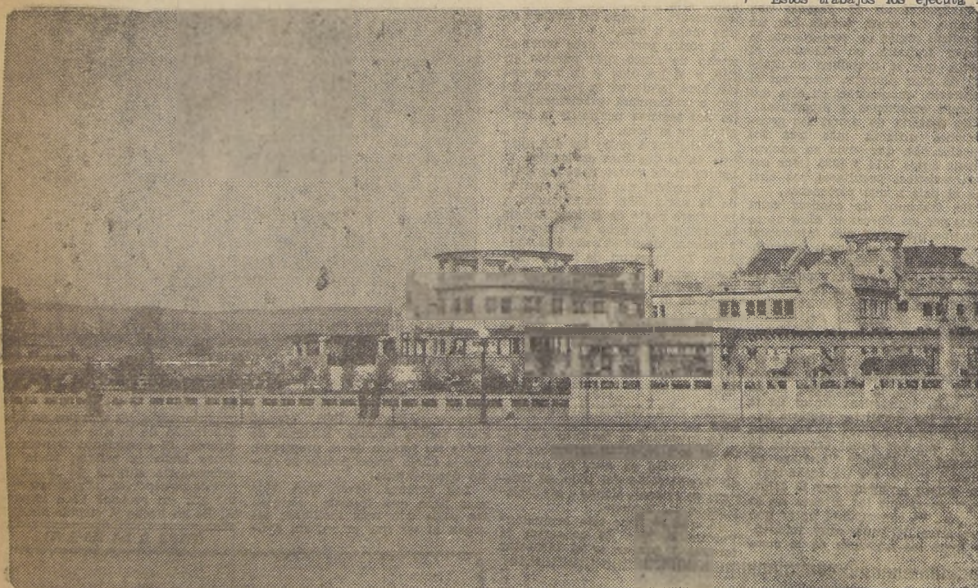
Vista parcial del Casino de Viña del Mar
