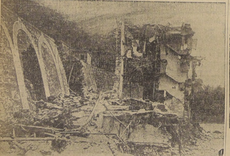
Las aguas deteniéndose distribuyeron la represa de la planta eléctrica en Ovada, Italia. Más de 15.000.000 de metros cúbicos de agua formaron un temible torrente que inundó el valle cercano, pereciendo ahogadas por lo menos 250 personas y causando destrozos que se calculan en $ 25.000.000 a los fértiles campos y la destrucción de edificios y puentes. La foto muestra a uno de los puentes arrasados por la terrible fuerza del torrente.
