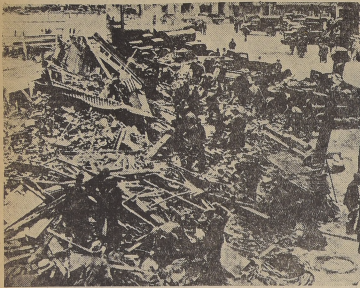
que cayó recientemente sobre Gainville, destruyó aproximadamente 163 hogares y otros 400 en el Sur. Este es un aspecto parcial de la zona atacada por el tornado.
