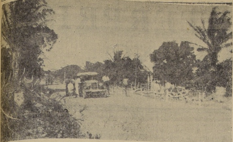
Camino Santa Cruz-Tarumá.— En el kilómetro 9.500 (Bajo) los caminos para vehículos a motor y los de tracción sangre van paralelos y separados con cerros de madera.
