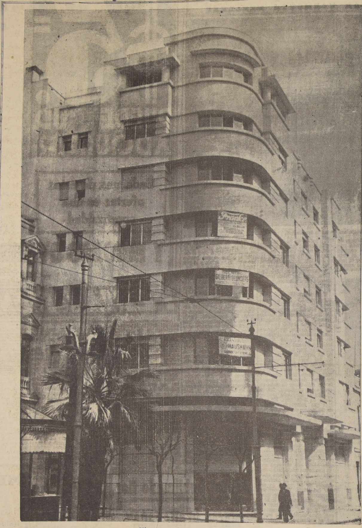
Vista en conjunto de esta moderna construcción
