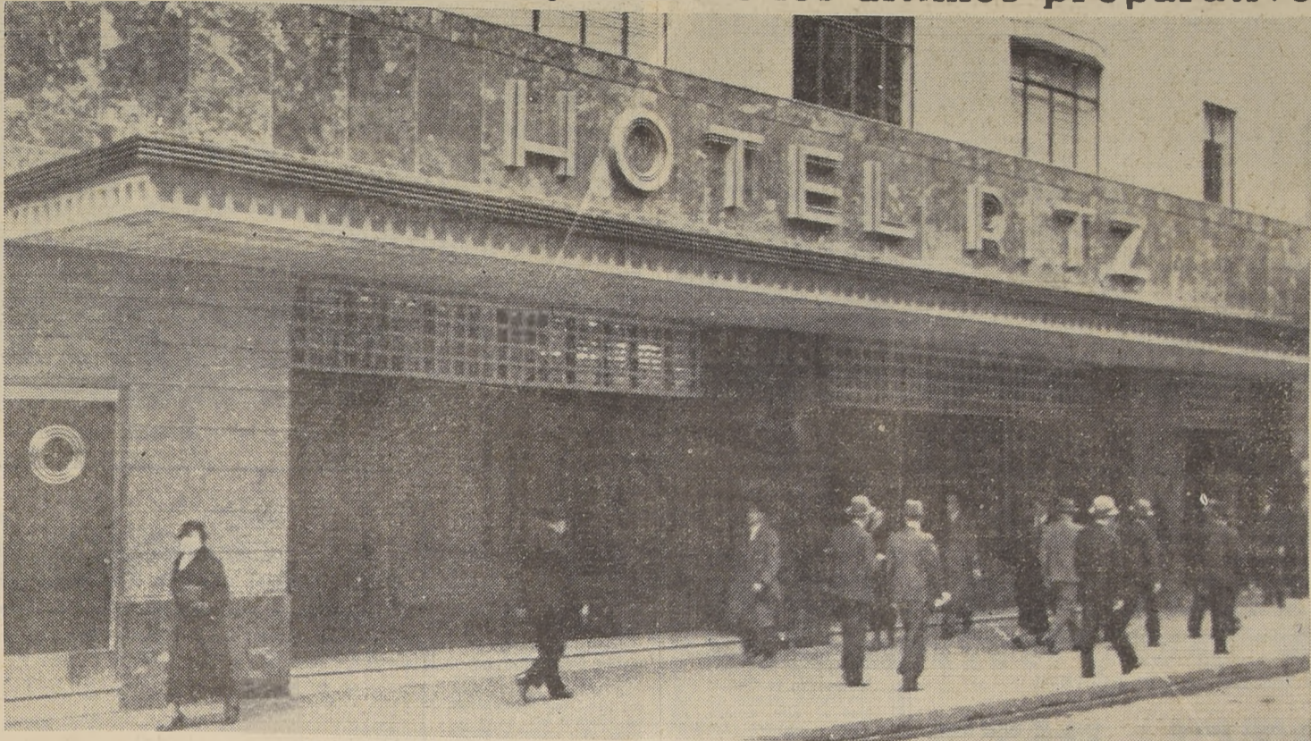
Entrada al Hotel Ritz, calle Estado
