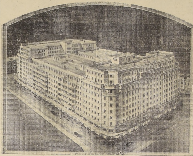
Proyecto del hermoso edificio del Banco de Chile, cuyo primer cuerpo está terminándose en la esquina de Ahumada y Agustinas por la Farmacia Germania, ocupando el primer y segundo pisos.
