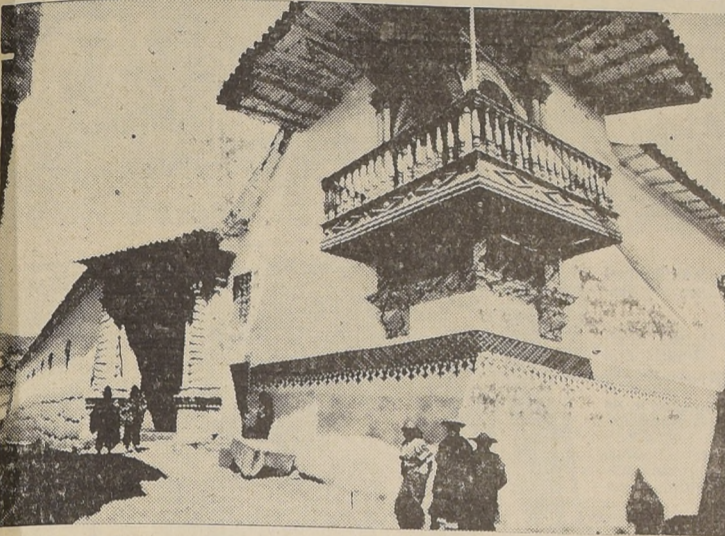
Uno de los más hermosos edificios de la época colonial en el Cuzco, es el llamado Palacio de "El Almirante"
