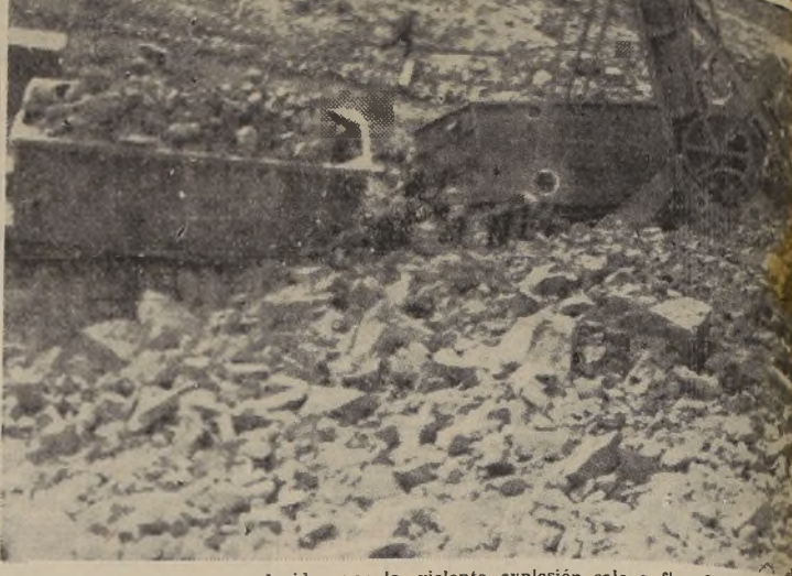
De entre los escombros producidos por la violenta explosión sale a flor de tierra esta grúa gigante destruida
