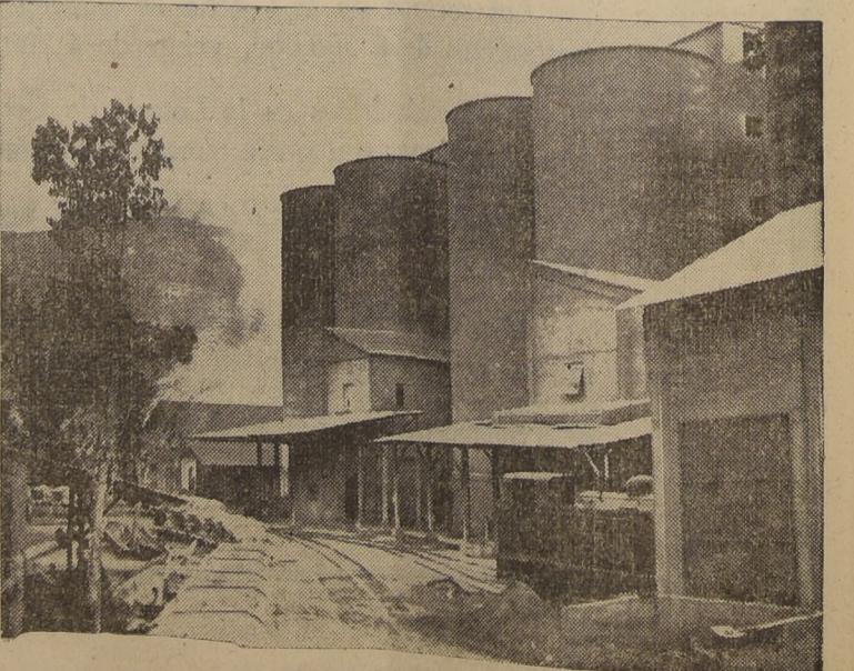
VISTA PARCIAL DEL PATIO
