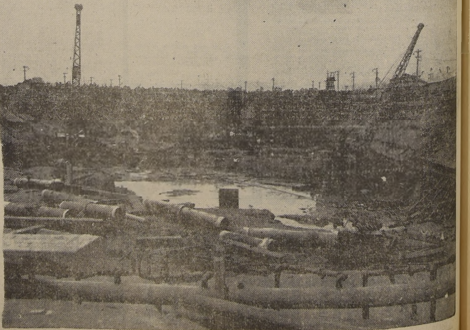
Un aspecto al poco tiempo de haberse iniciado los trabajos
