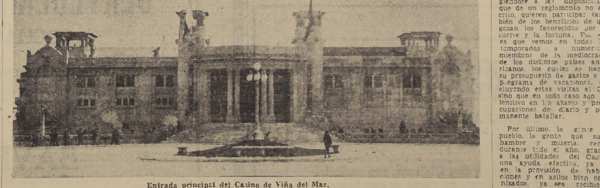
Entrada principal del Casino de Viña del Mar.
