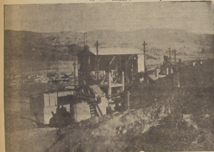
CAJA DE CREDITO MINERO.— Filtro Moore de la Sección Cianuración de la planta de "El Salado".
