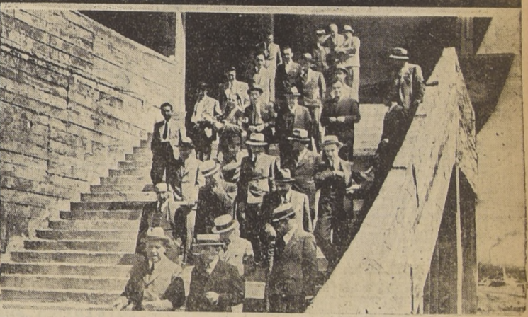
El Ministro de Hacienda, don Francisco Garcés Gana, acompañado de algunos funcionarios públicos y obreros de las obras del Estadio Nacional. Un aspecto de las tribunas en construcción. El Ministro de Estado y comitiva al retirarse después de su visita al Estadio Nacional.
