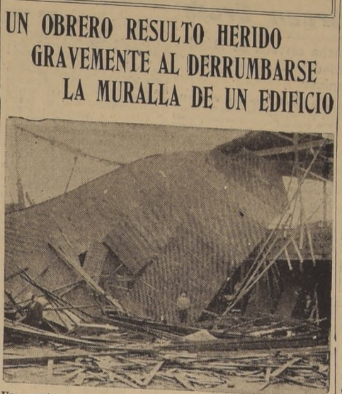
Un aspecto del derrumbe de una muralla del edificio del antiguo Teatro "Cine Mundial" ubicado en la Plaza Almagro. El accidente ocurrió ayer, a las 16.30 horas...
