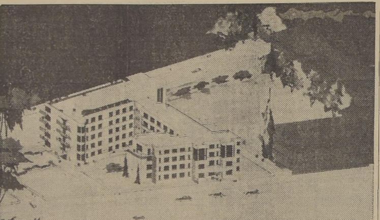
Hospital Clínico de la Universidad Católica, actualmente en construcción
